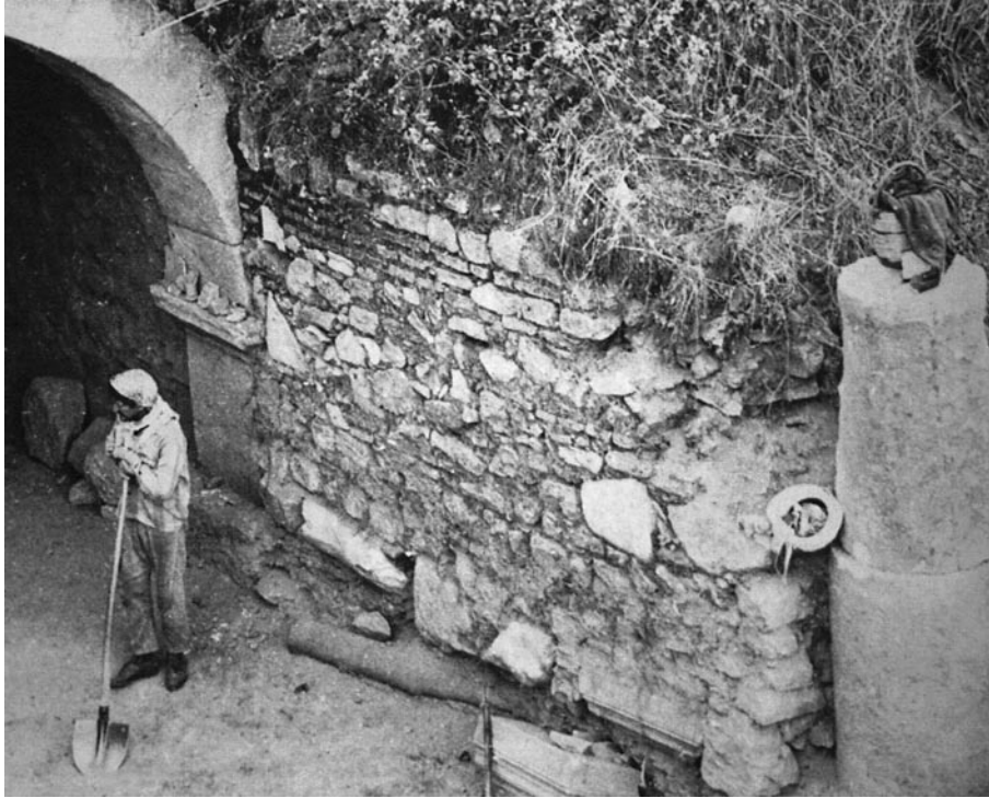
4 Ephesos, sog. Domitiansterrasse: Spolienmauer vor dem Eingang zur Kryptoportikus an der westlichen Terrassenfront
